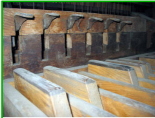
Les cuillers ont été modifiées et rehaussées. Une traverse en sapin a été ajoutée.
