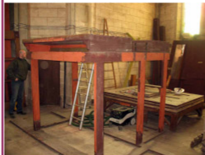
La charpente et les sommiers
