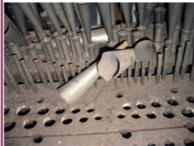
Dépose de la tuyauterie du GO.
