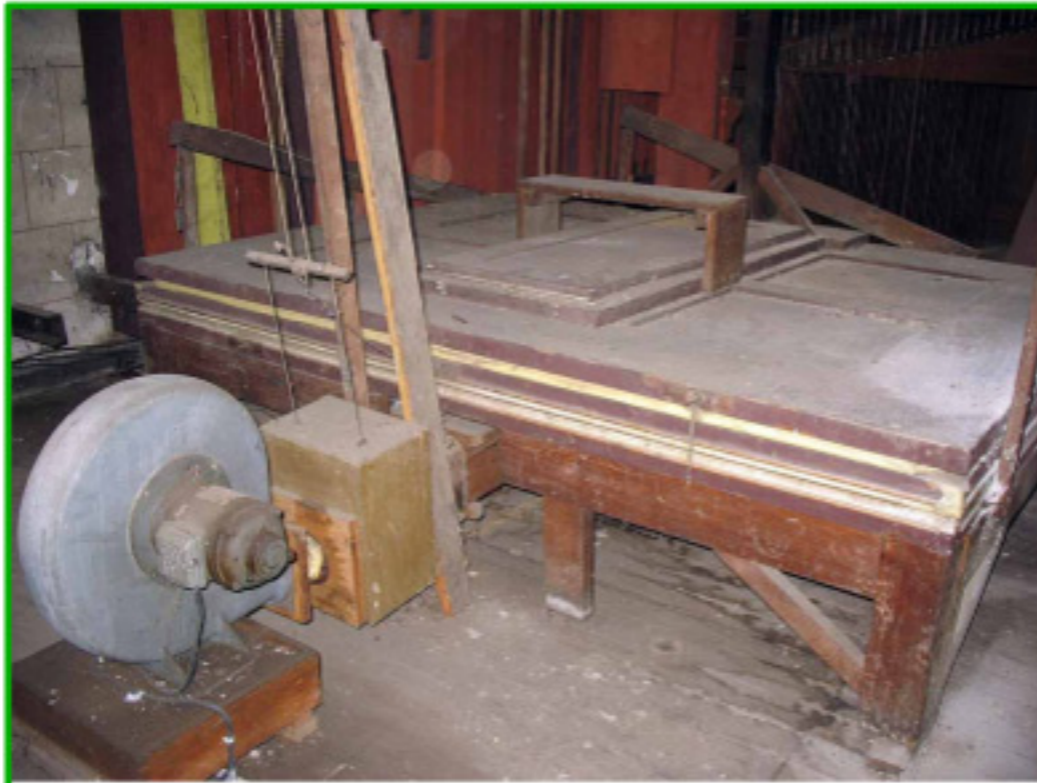
La Soufflerie État délabré de la soufflerie.
